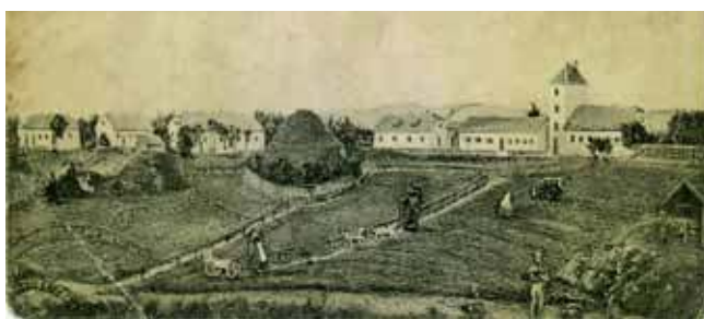
Panorama zakładu od strony południowo-wschodniej, Friedrich Roesner, Tarnowskie Góry, 1913 r.
