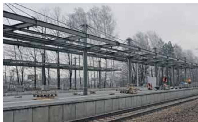
Nowa stacja Pyrzowice Lotnisko
