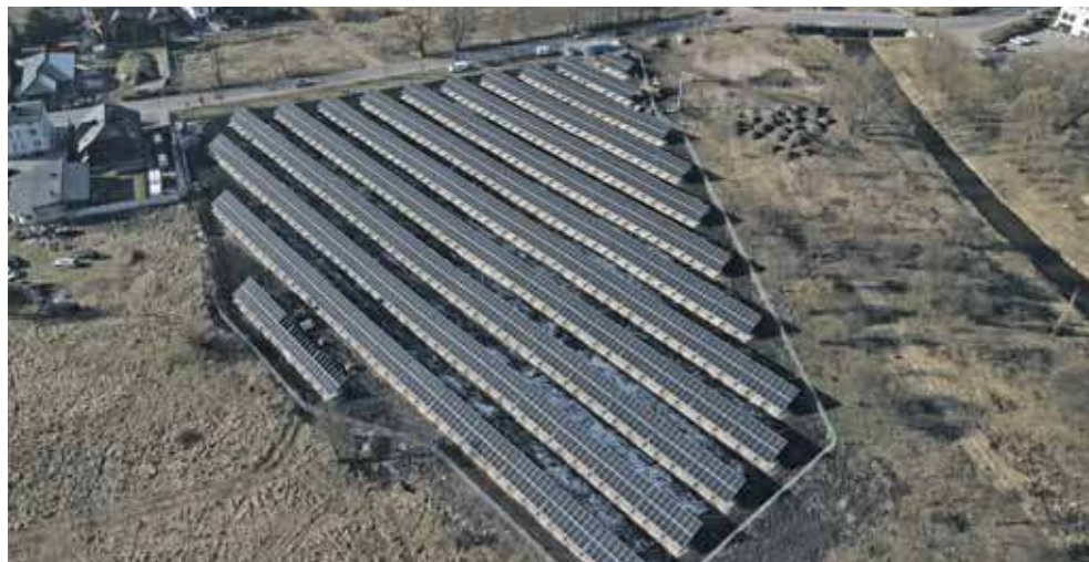
W Kaletach powstaje duża instalacja fotowoltaiczna
