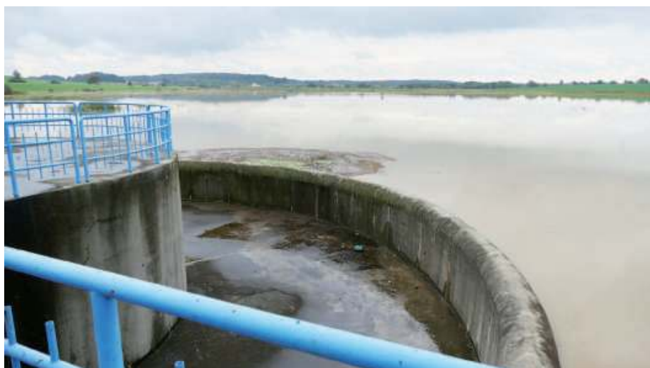
Zbiornik zalewowy w Przewornie 15 października br. musiał zmierzyć się z olbrzymim naporem wody. Do przelania się przez pierścień zabezpieczający zabrakło około 30 cm. Sytuacja trwała raptem dobę i zbiornik nadal jest pusty...
