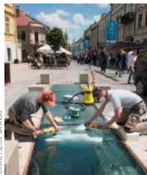
Zamiast płacić ponad 200 tys. zł za wymianę okna czasu, wystarczyło tylko wypolerować
