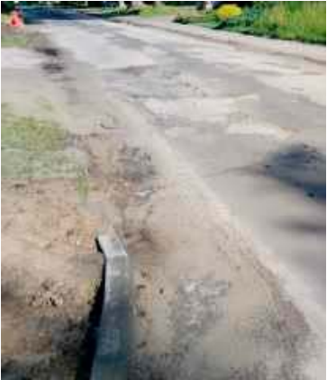
Remont objął tylko niewielki fragment ulicy Wiejskiej, większość pozostała „po staremu”
