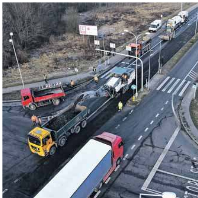
Drogowcy remontują obwodnicę w Tarnowskich Górach
