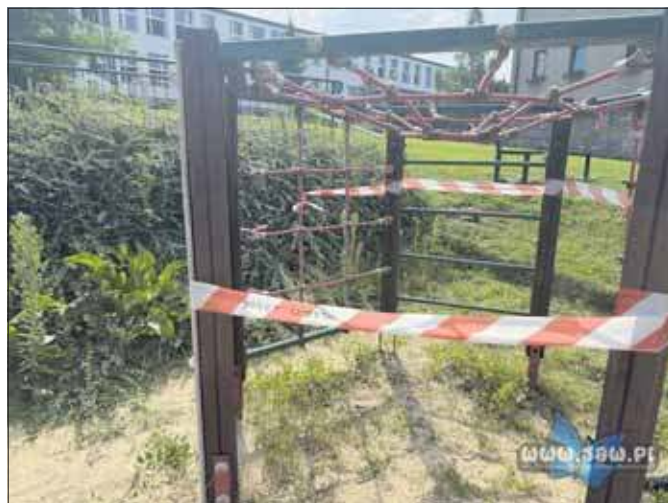
Zniszczony plac zabaw w Byczynie
