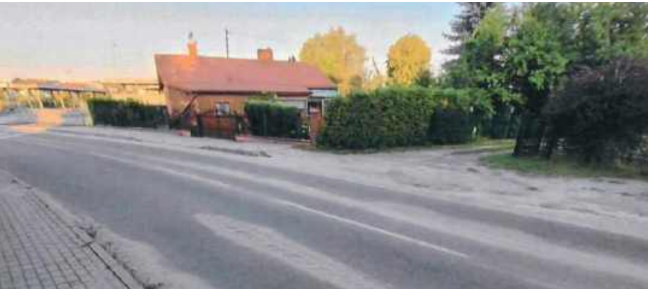
Tak ulica wyglądała w lecie. Widoczne jest zanieczyszczenie
