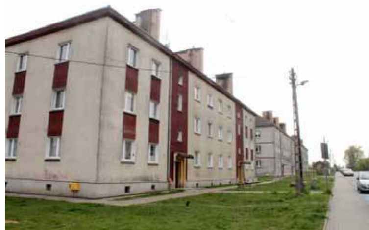
Głównym źródłem ciepła na Os. Kluczewo są kotłownie gazowe
