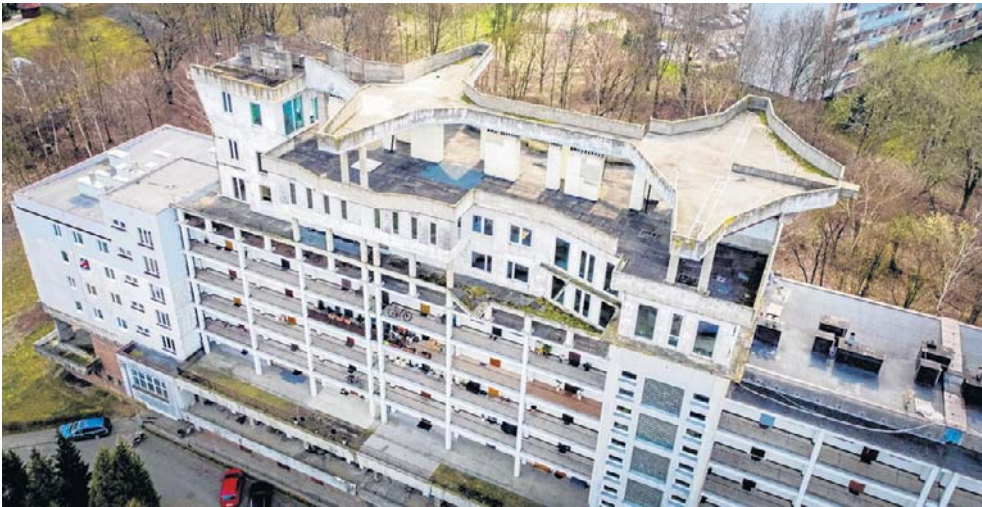
Część nadbudowy została już rozebrana
