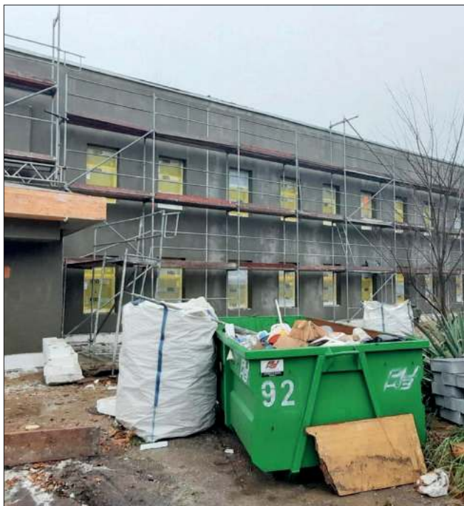
W budynku wodzisławskiego oddziału wewnętrznego trwają obecnie prace związane z termomodernizacją, ale też modernizacją zewnętrznej sieci centralnego ogrzewania i ciepłej wody użytkowej
