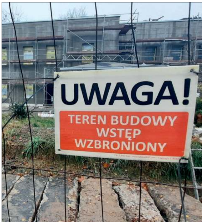
Zakończenie wszystkich prac – zarówno tych zewnętrznych jak i wewnętrznych mają zakończyć się z końcem września przyszłego roku
