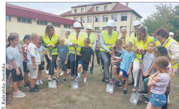
Do końca 2026 roku mają zakończyć się prace przy budowie przedszkola w Nowym Duninowie
