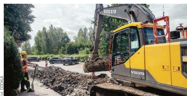
Przebudowa DK22 od Królewa do granicy woj. pomorskiego
