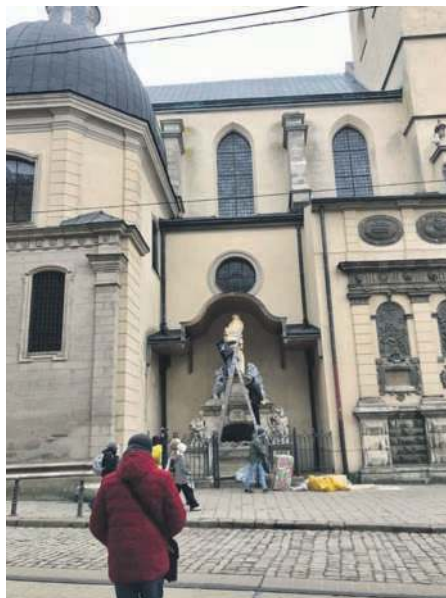
Zabezpieczenie rzeźby folią ochronną
