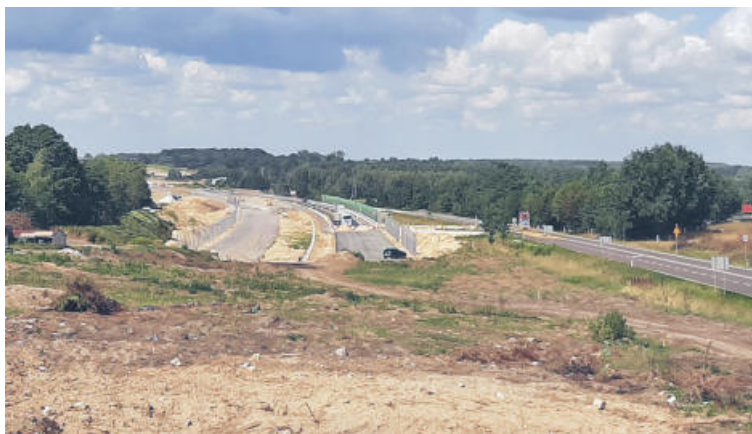
Budowa autostrady trwa.
