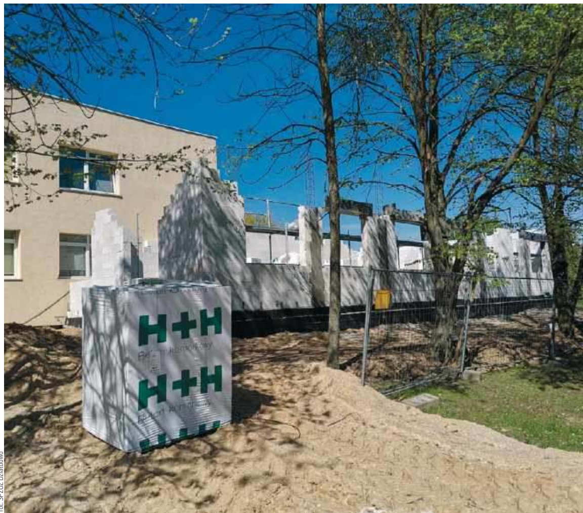
Rozbudowa Oddziału Psychiatrycznego
