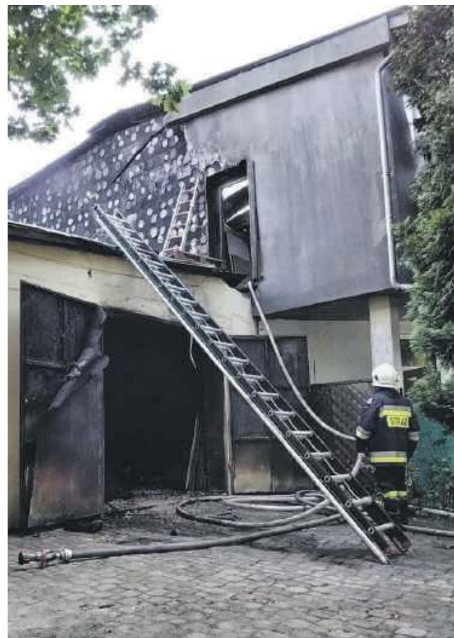
Ogień przemieścił się do remontowanego mieszkania
