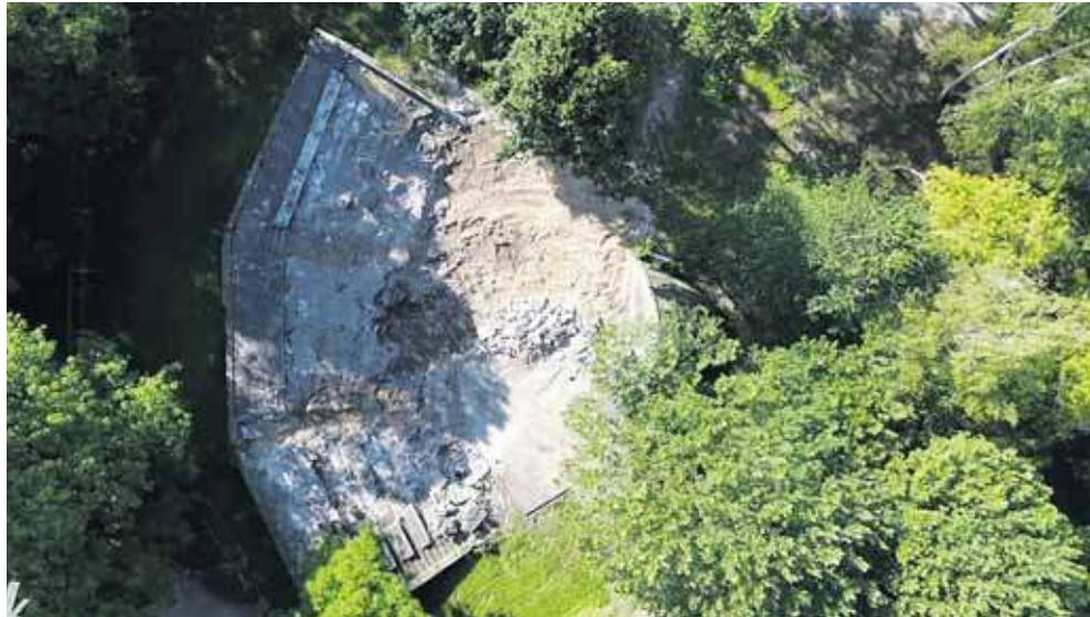
Rozpoczęły się pierwsze prace ziemne, czyli rozbiórka widowni
