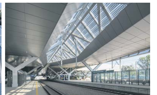
Dworzec Zachodni w Warszawie - zadaszenie BIPV od ML System o mocy 1,1 MWp
