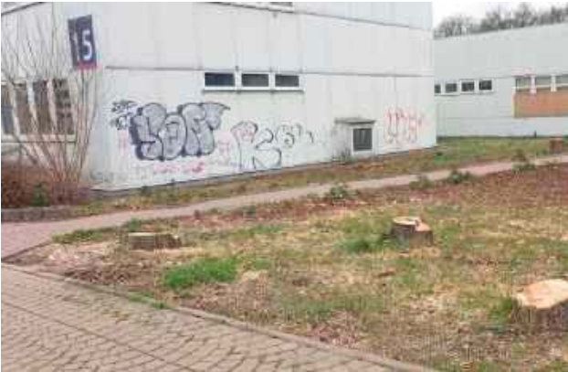
Budynki po urzędzie miasta czekają na pozwolenie na rozbiorę
