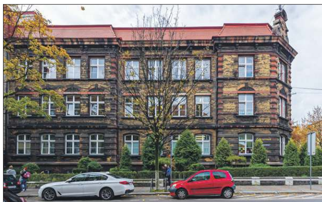
SP nr 4 zyska nową elewację
