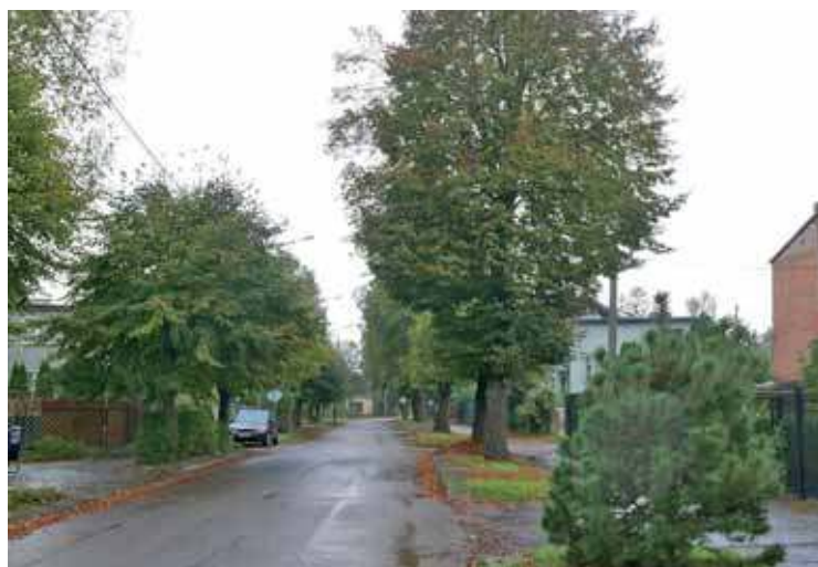
Ulica Stare Miasto: droga wymaga remontu, a drzewa pielęgnacji
