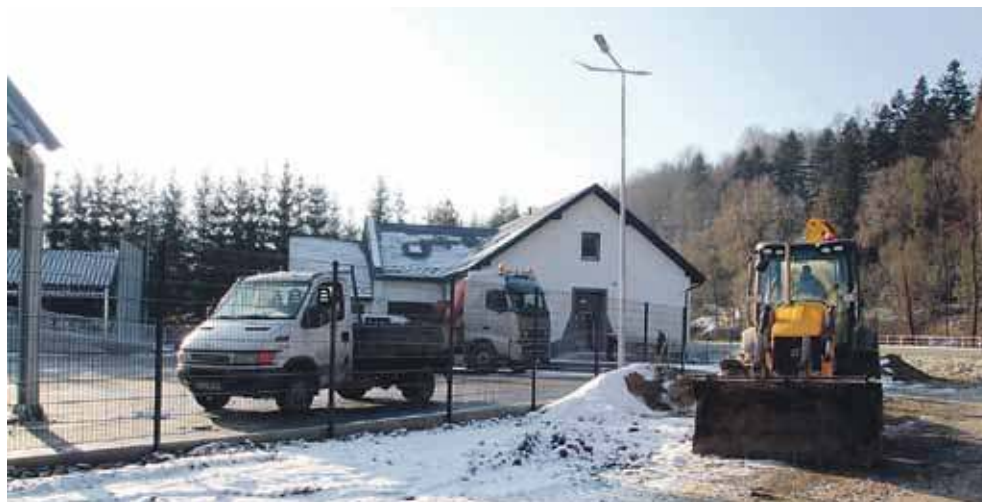
Budowa PSZOK-u w Krościenku jest prawie na finiszu.
