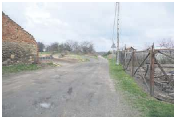
Remont drogi gminnej w Wyszonowicach rozpocznie się od skrzyżowania w centrum miejscowości
