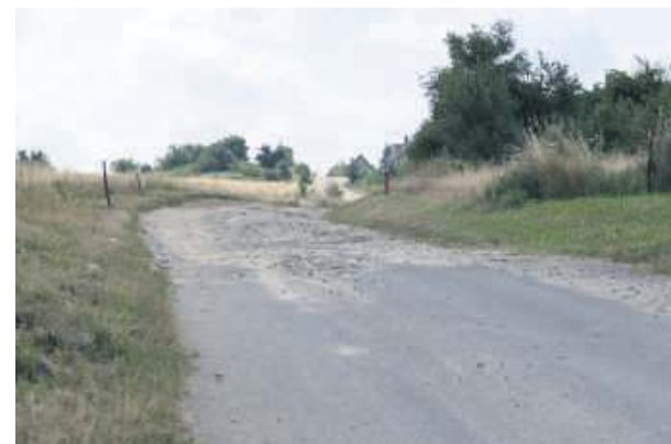
W tym roku gmina Strzelin planuje utwardzić fragment ulicy Sosnowej w Gęsińcu
