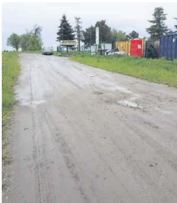
Remont drogi na PSZOK będzie kosztował ponad 400 tys. zł
