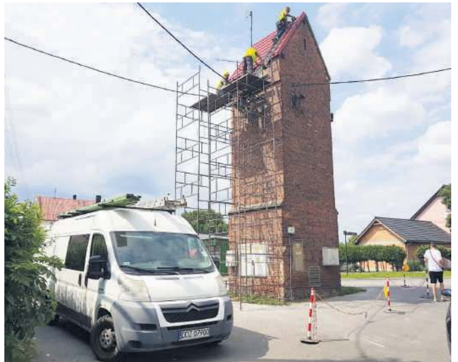
W ubiegłym tygodniu mieszkańcy Przeworna nie mieli w mieszkaniach prądu. W tym czasie elektrycy remontowali m.in. dach na budynku, w którym stoi transformator
