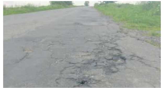
Kolejny odcinek drogi z Wiązowa w kierunku Jędrzychowic już niebawem doczeka się remontu
