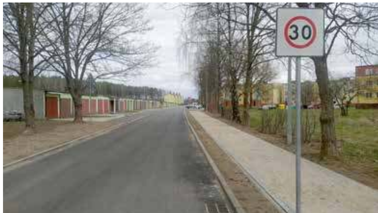
Z nowej nawierzchni na ulicy Leśnej mieszkańcy mogą korzystać już od kilku miesięcy. Płatności i w tym przypadku dla wykonawcy dalej brak
