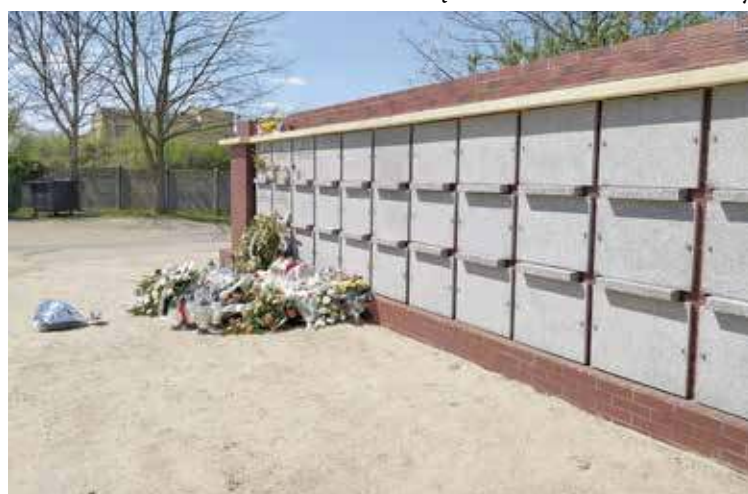
Ścianka urnowa została ukończona na początku kwietnia a oddana w maju
