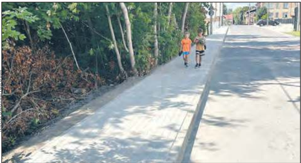
■ Chodnik o szerokości 1,5 metra został wykonany na długości ponad 300 metrów
