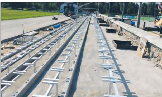
■ Trwają prace przy przebudowie trybuny dla kibiców oraz bieżni lekkoatletycznej
