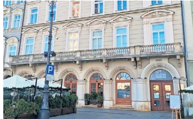
Międzynarodowe Centrum Kultury szykuje się do remontu kamienicy „Pod Kruki”
