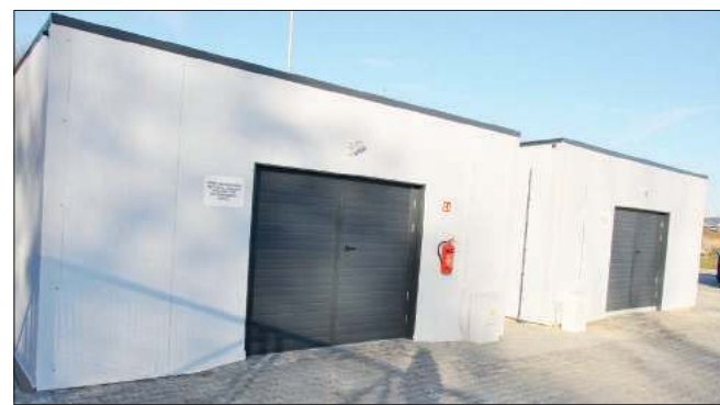
■ Nowy PSZOK przy ulicy Traugutta w Pszowie – Kontenery: Punkt napraw oraz przyjęcia i odbioru przedmiotów do ponownego użycia, Magazyn odpadów niebezpiecznych i zużytego sprzętu elektrycznego i elektronicznego
