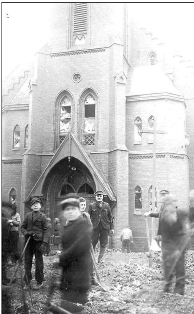
■ Na zdjęciu widać m.in. zniszczone witraże kościoła
