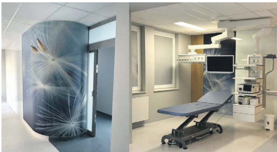
Pracownia endoskopii w świeżo wyremontowanych pomieszczeniach
