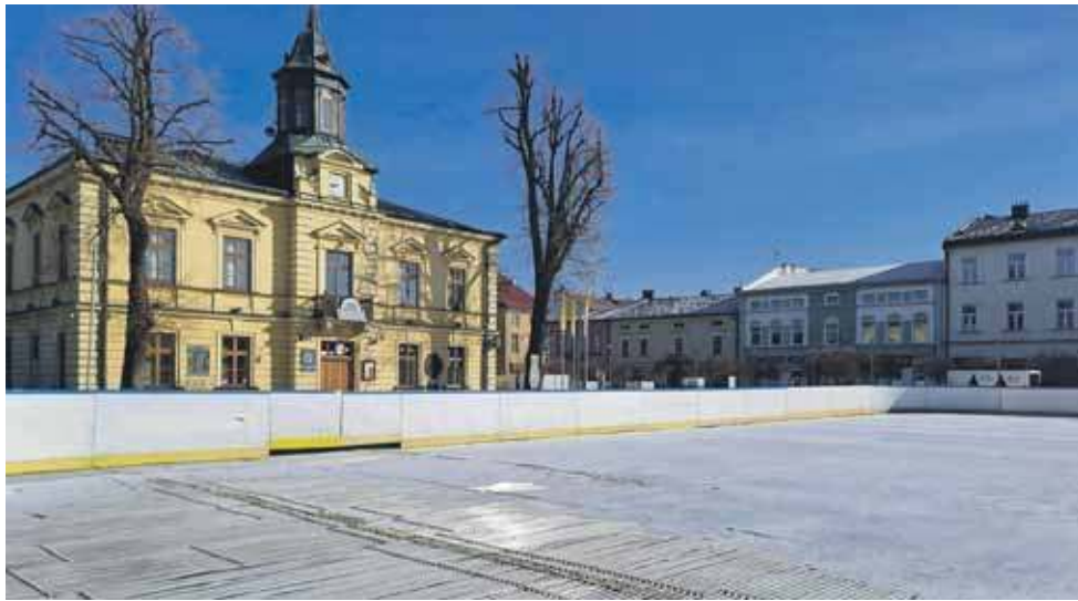
Tafla lodowiska powoli odmarza - na demontaż instalacji poczekamy jeszcze blisko dwa tygodnie.
