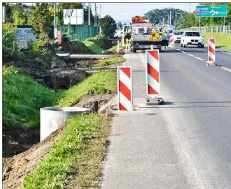
Prace w Pustyni powodują utrudnienia w ruchu. Fot. UG w Dębicy.
