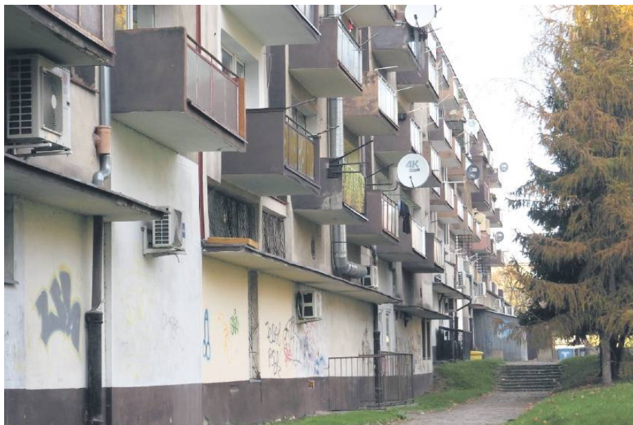
W bloku mają zostać wzmocnione balkony. Położona zostanie też hydroizolacja i odnowiony dach
