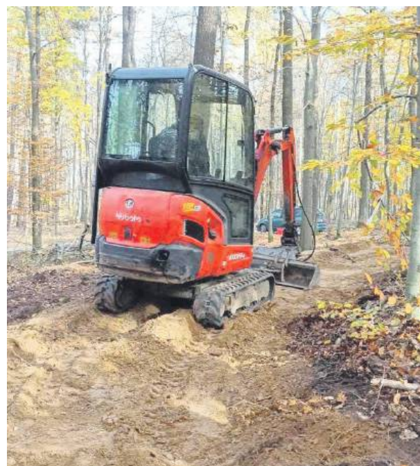
Trwają prace przy budowie piątej trasy single track na terenie gminy Strzelin. Fot. UMiG Strzelin
