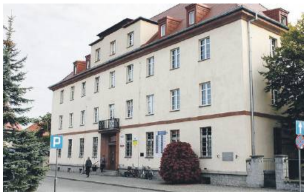
Audyt energetyczny wykazał, że termomodernizacja budynku strzelińskiej przychodni jest konieczna
