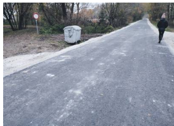
Dziś skrótom z Dębink aż do Gębczyc pojedziemy w całości po asfalcie. Przed Świętem Niepodległości wykonawca położył asfalt na remontowanym odcinku
