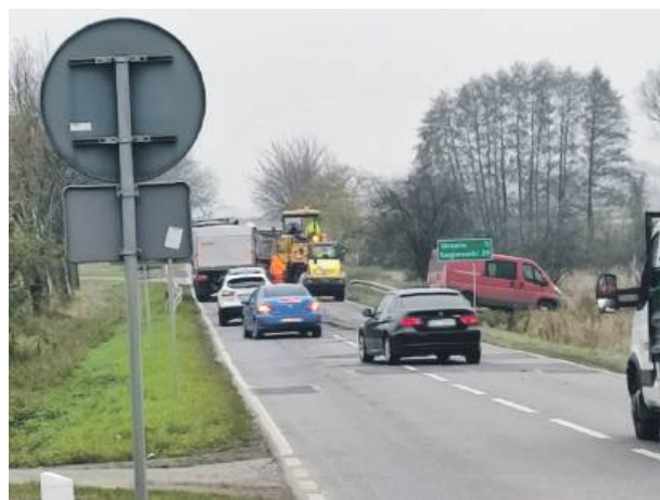
W miniony piątek w Wiązowie i Starym Wiązowie remontowane były fragmenty drogi krajowej nr 39
