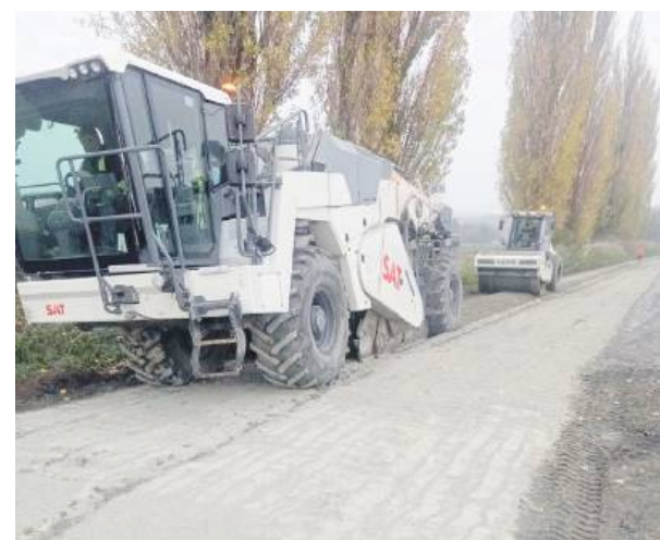
W minionym tygodniu na drogach powiatowych po raz pierwszy zastosowano stabilizator gruntu WR 200i. Fot. PZD
