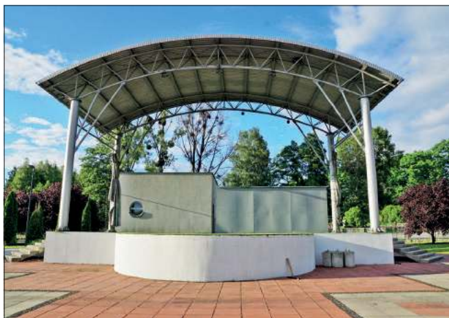
Okazuje się, że scena znajdująca się na terenie Słonecznej Wyspy ma wiele niedociągnięć przede wszystkim technicznych. Jej wysokość nie została dostosowana do niekorzystnych warunków atmosferycznych. W efekcie, kiedy pada deszcz, zasieka on do jej wnętrza.
