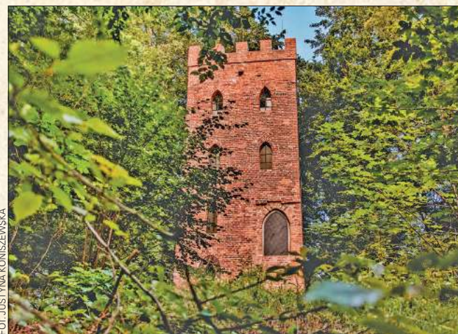
Baszta dziś, przed planowaną rewitalizacją
