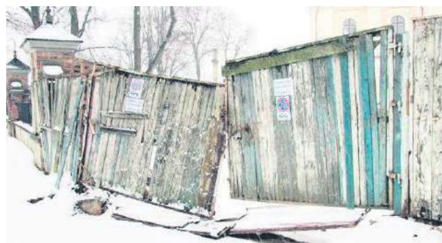
Tak brama wjazdowa na budowę wyglądała jeszcze na początku lutego.
