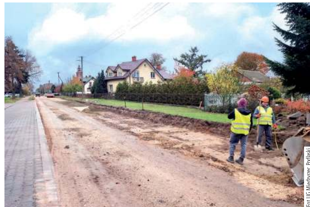
Obecnie prace odbywają się na wysokości Szkoły Podstawowej w Krzewicy
