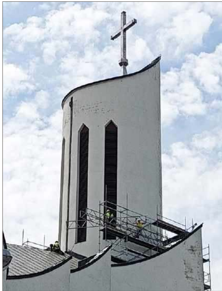
Dwa tygodnie zajęła budowa samych rusztowań przy kościelnej wieży.
