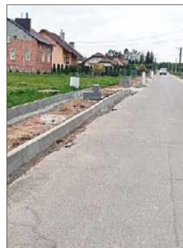
Prace już się rozpoczęły.
