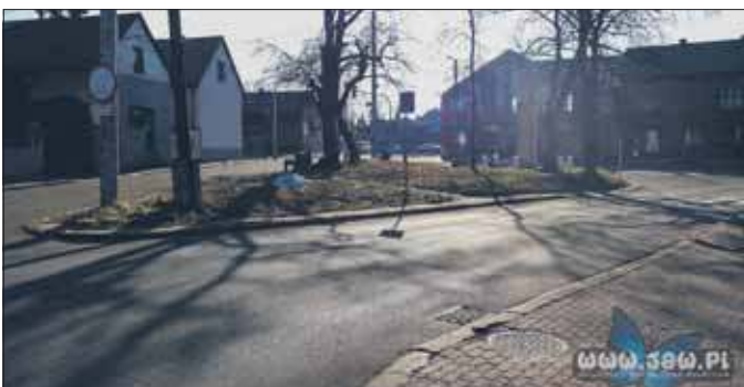
Starodroże zaplanowane do przebudowy
