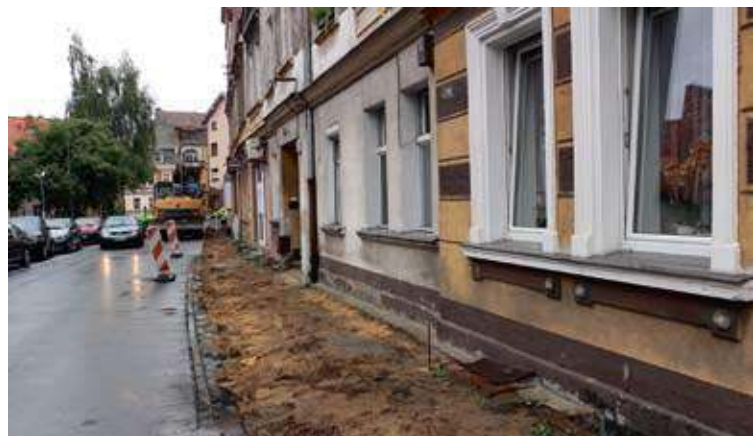
Trwa remont przy ul. Traugutta
