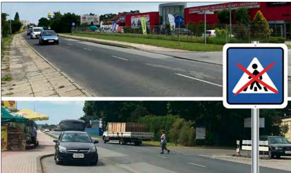
Na ulicy Prudnickiej w Krapkowicach brakuje przejścia dla pieszych.
