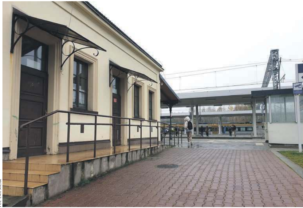
Boczna ściana budynku dworca PKP w Trzebini, gdzie kiedyś funkcjonowała publiczna toaleta. Od kilku miesięcy nie działa.
