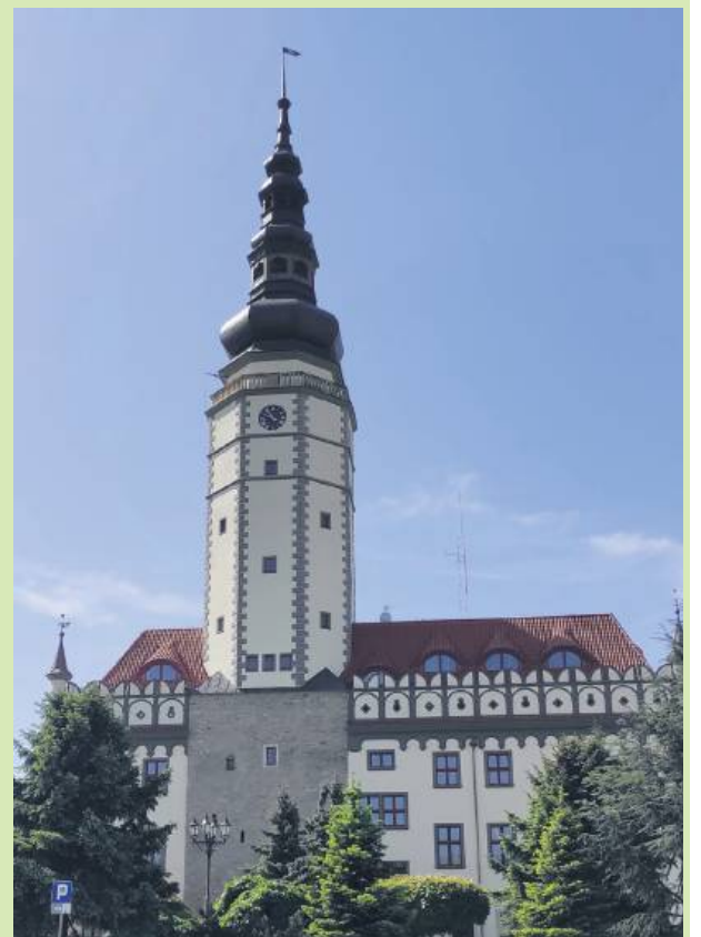
Spółka Strzeliński Ratusz jest właścicielem odbudowanego ratusza, a gmina Strzelin będzie wynajmować w nim pomieszczenia
