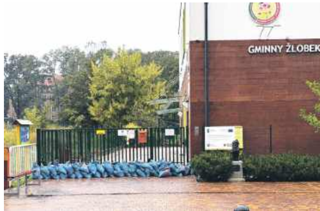
Żłobek szczelnie obłożony workami
