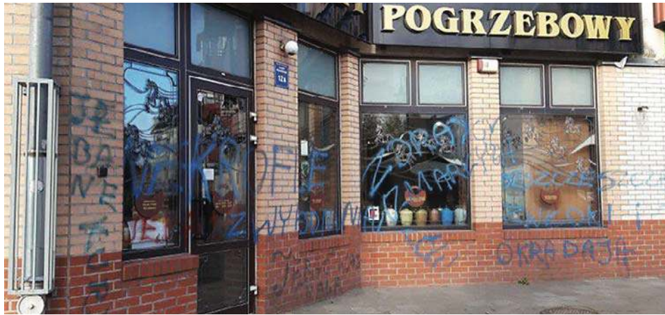
10 października siedziba zakładu została zdewastowana
