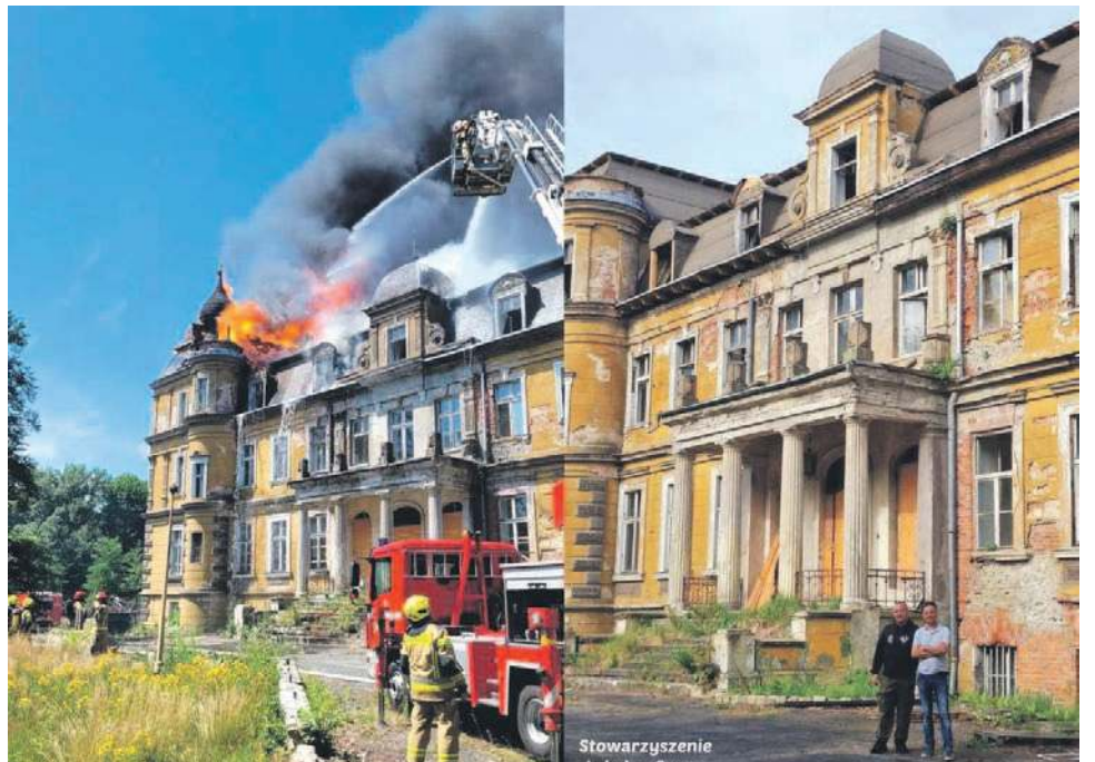
Efekty prac widać gołym okiem
