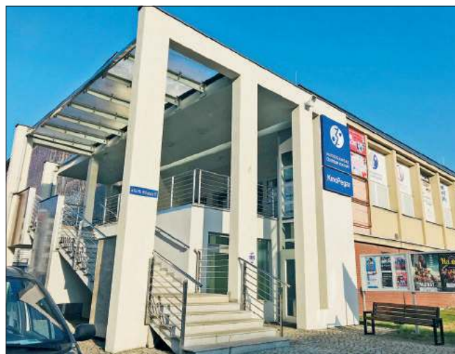
Na dachu budynku Wodzisławskiego Centrum Kultury do końca sierpnia zostanie zamontowana instalacja fotowoltaiczna
