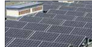
Zakończono montaż instalacji fotowoltaicznych na budynkach użyteczności publicznej powiatu łosickiego
