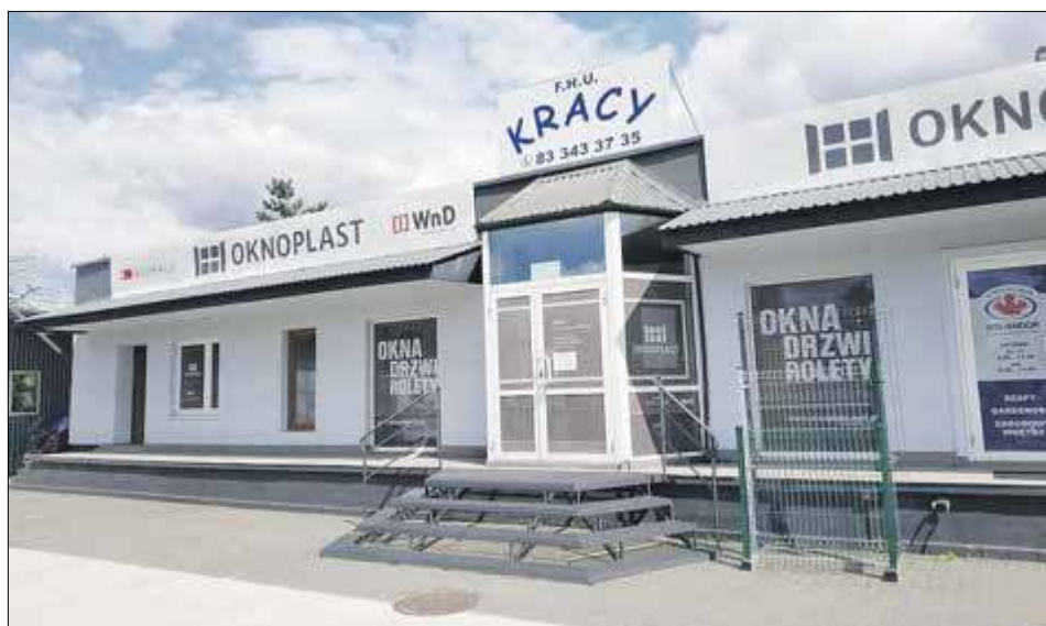
Zapraszamy do salonu sprzedaży partnera handlowego Kracy przy ul. Leszczynowej 3a w Białej Podlaskiej
