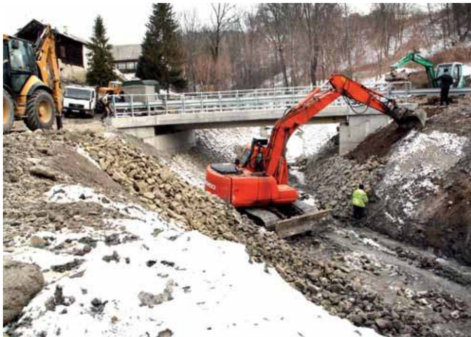
Ostatnie prace przy moście na potoku Sielskim w Szlachtowej.
