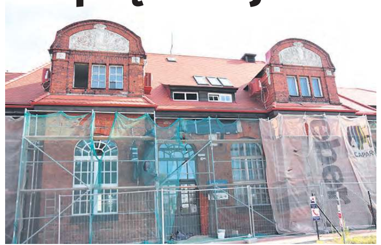
Tył dworca i trwające obecnie prace w zakresie odnowienia elewacji.
