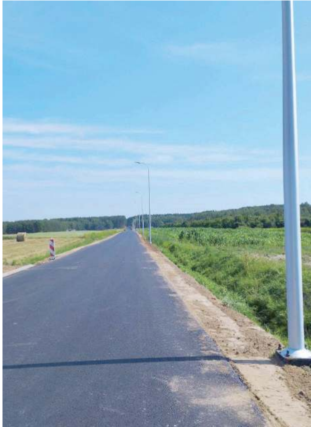
W miejscu wygonu powstała gminna droga, z oświetleniem LED
