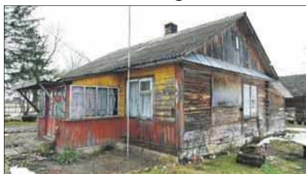
Dom Anny Iwaniuk przed remontem wymagał wymiany dachu i pieców oraz wielu innych prac
