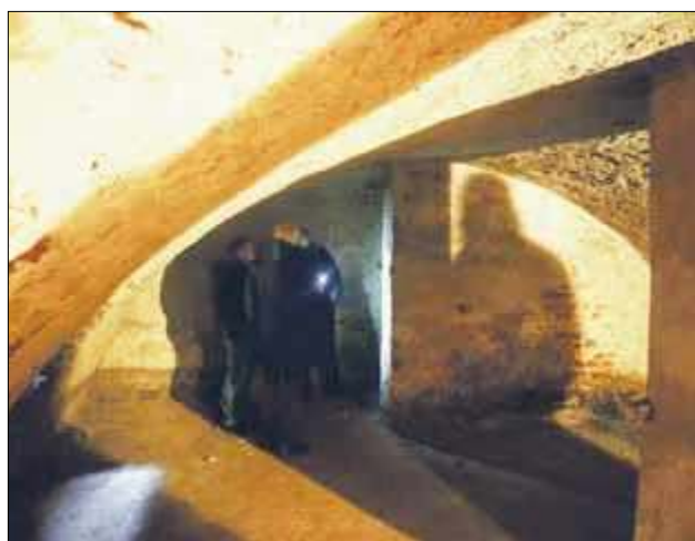
W oficynie na terenie Placencji wcześniej mieściło się przedszkole, a potem budynek stał przez dwa lata pusty. Gmina pozyskała fundusze na modernizację obiektu. Na etapie projektowania wiedzieliśmy, że piwnice istnieją – mówi sekretarz gminy Mariusz Zańko
