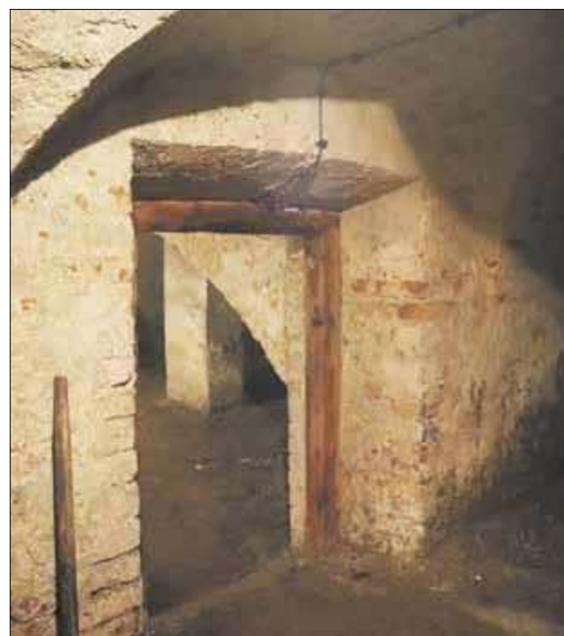
– Piwnice są zachowane w świetnym stanie, są bardzo dekoracyjne, gmina postarała się, by zostały wysprzątane – mówi konserwator zabytków Jan Maraśkiewicz
