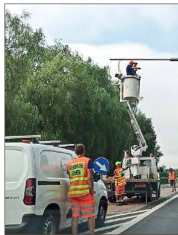
Urządzenia już są zamontowane.
