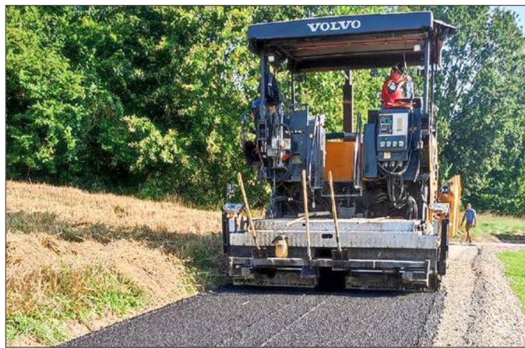
Eurovia skończyła. Pozostałe drogi mają być gotowe we wrześniu.
