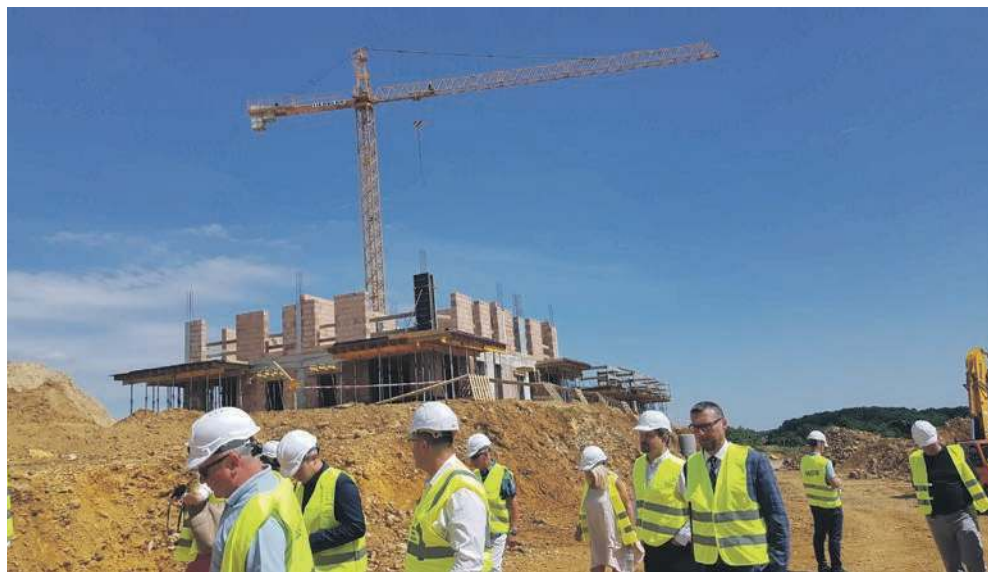
W tym roku zostanie osiągnięty stan surowy zamknięty pierwszych dwóch budynków. Więcej zdjęć i wideo możecie obejrzeć na przelom.pl
