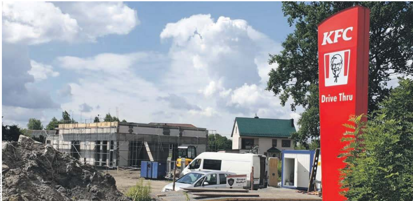
Szyld restauracji już widać z krajówki
